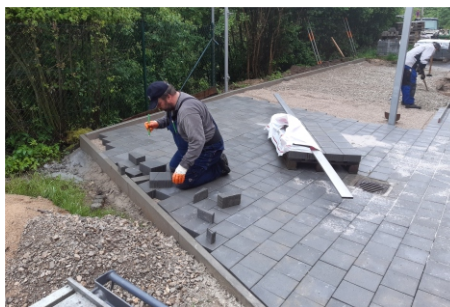
Arbeiten vor dem Freibad; Foto: FV Freibad Hirschbach
